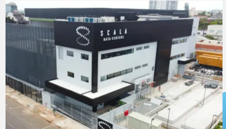
Scala Data Center – São João de Meriti
